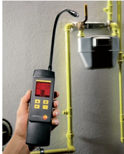
Рис. 20: Обнаружение утечки в газовых трубах с помощью testo 316-2
